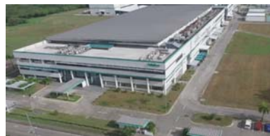
フィリピン日本電産スービックの建屋を活用
