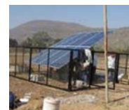
ソーラーパネルの設営
