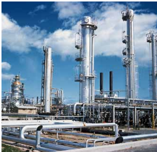
アンサルド社が電気設備一式を受注したプラント
