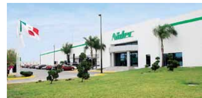
日本電産モータ(メキシコ工場)
