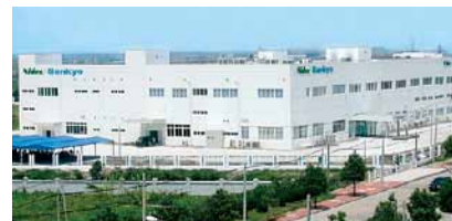
日本電産三協(浙江)有限公司 第3工場
