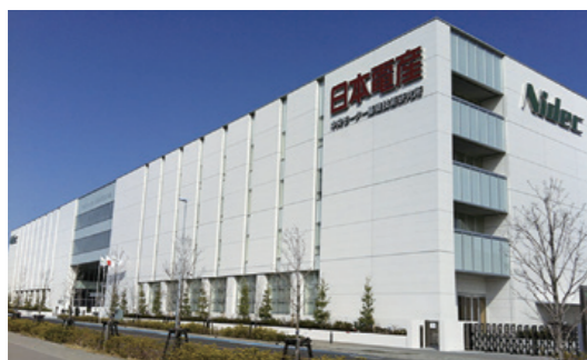
中央モーター基礎技術研究所 (川崎)
